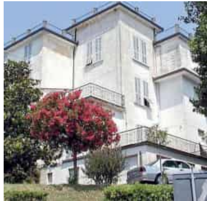
L'ospedale San Nicolò di Levanto riaprirà a marzo dopo i lavori
