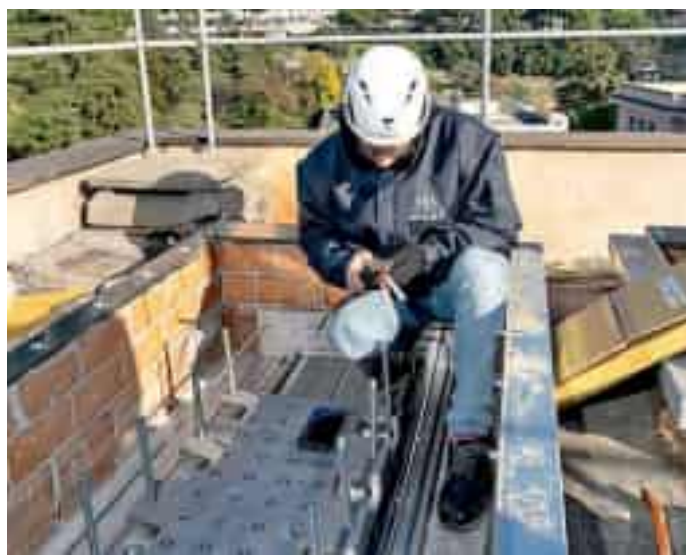
Alcune fasi dell'installazione del nuovo sistema antisismico sul tetto del Padiglione Specialità dell'ospedale San Martino
