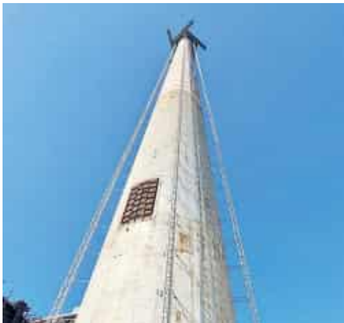
La ciminiera Enel a Vallegrande che sarà demolita
