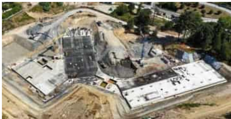
A sinistra, una panoramica dall'alto delle fondamenta del nuovo ospedale, realizzata con il drone. A destra, operai al lavoro all'interno del cantiere del Felettino
