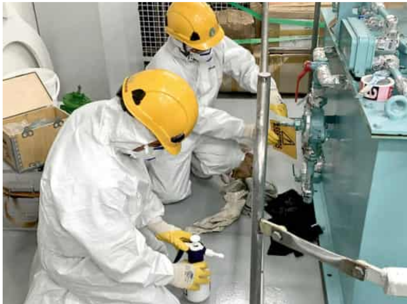
Operazioni di bonifica da amianto su una nave
