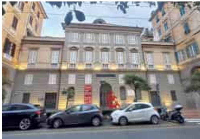
La sede di Fondazione Carispezia
