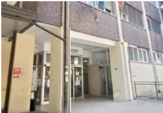
L'ingresso della sede Asl5 in via XXIV Maggio
